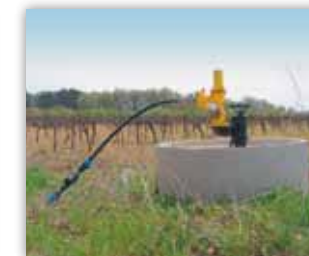
▲ Prélèvement sur réseau sous-pression
